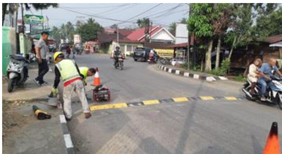
Gambar 2.12 Pemasangan Speedbump
