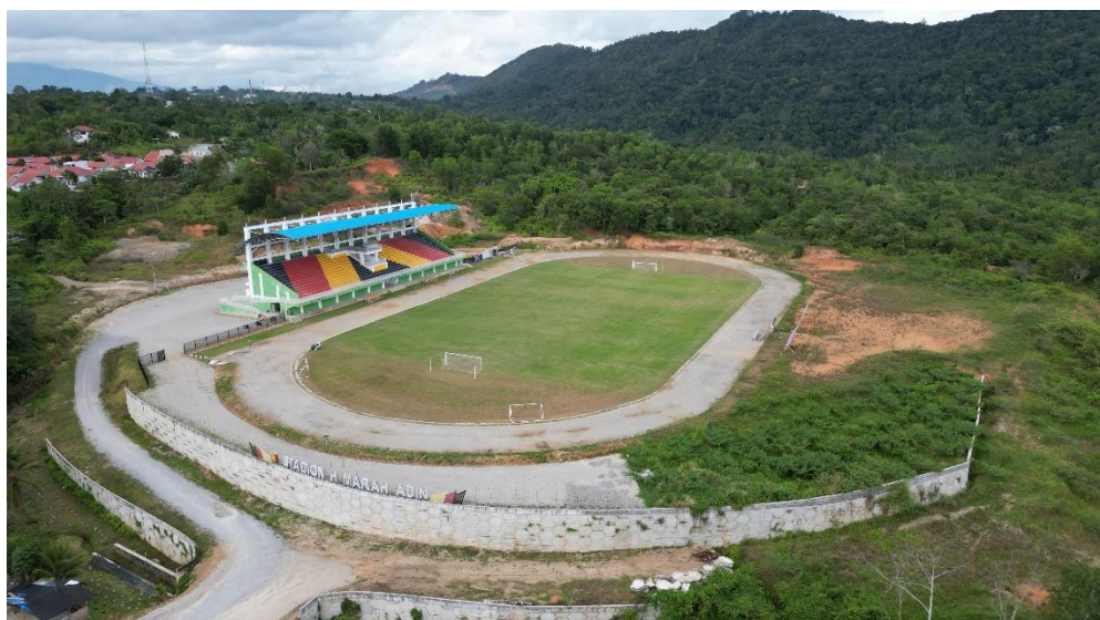
Gambar 4.2 Kondisi Stadion H. Marah Adin Kota Solok
